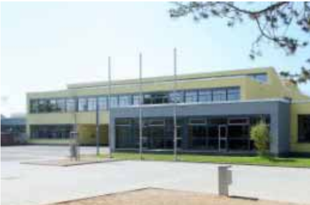
Foto 8: Schulgebäude der Gesamtschule Obere Aar
