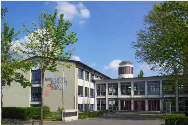
Foto 7: Schulgebäude der Berufsschule Groß-Gerau
