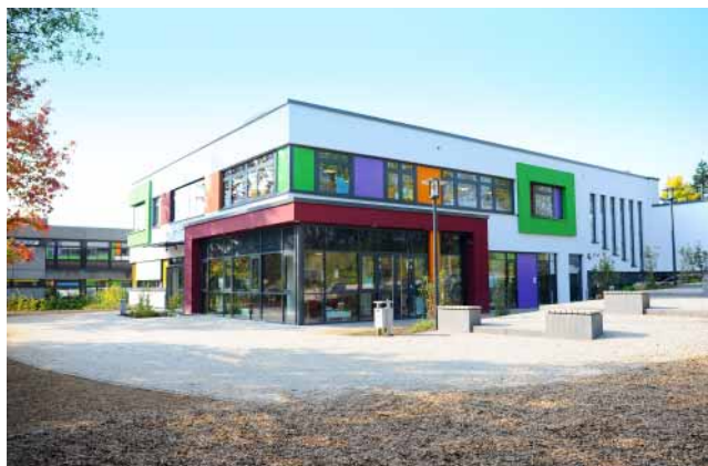
Foto 8: Schulgebäude der Gesamtschule Obere Aar
